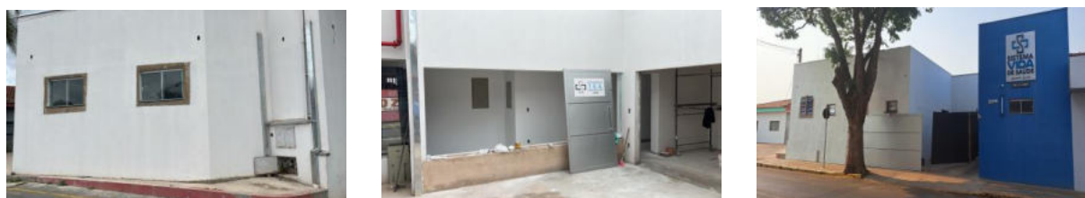
Obras do TEA
