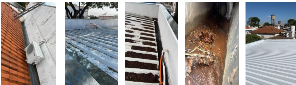
Limpeza de Calhas e Coberturas
