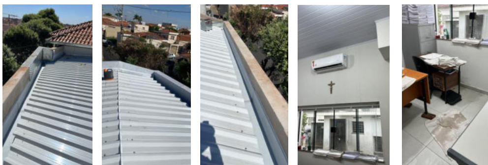
Troca do telhado
