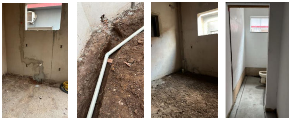
Obras do TEA
