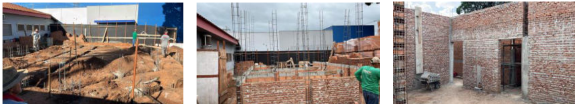
Obras do TEA
